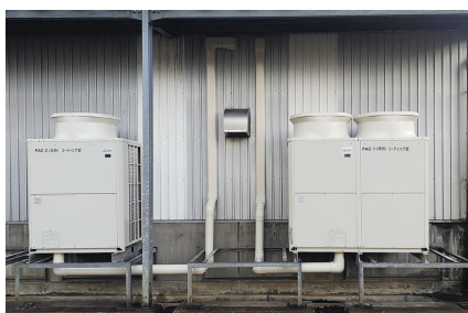
省エネ型空調機に更新しました。
